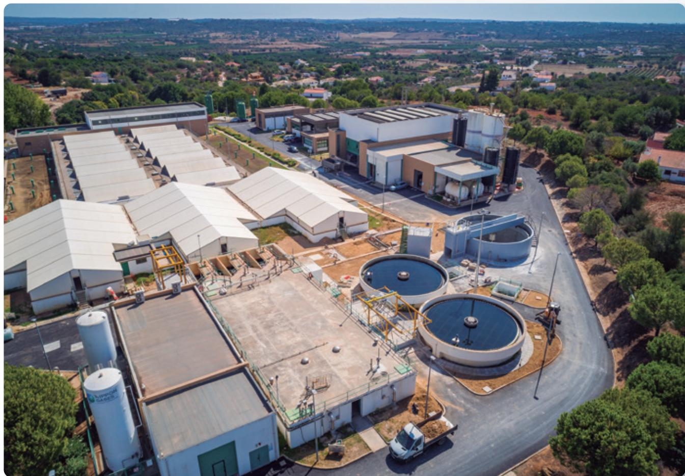
La potabilizadora está constituida por una línea convencional de tratamiento del agua con pre-oxidación por ozono, decantación/espesamiento (tecnología "Densadeg") y filtración rápida, y por una línea de tratamiento de fangos, también por decantación, que permite recuperar el agua de lavado de sus filtros. Sus líneas de decantación/espesamiento fueron diseñadas para caudales de hasta 1000 l/s y la ETAP para 259.2000 m<sup>3</sup>/día.
