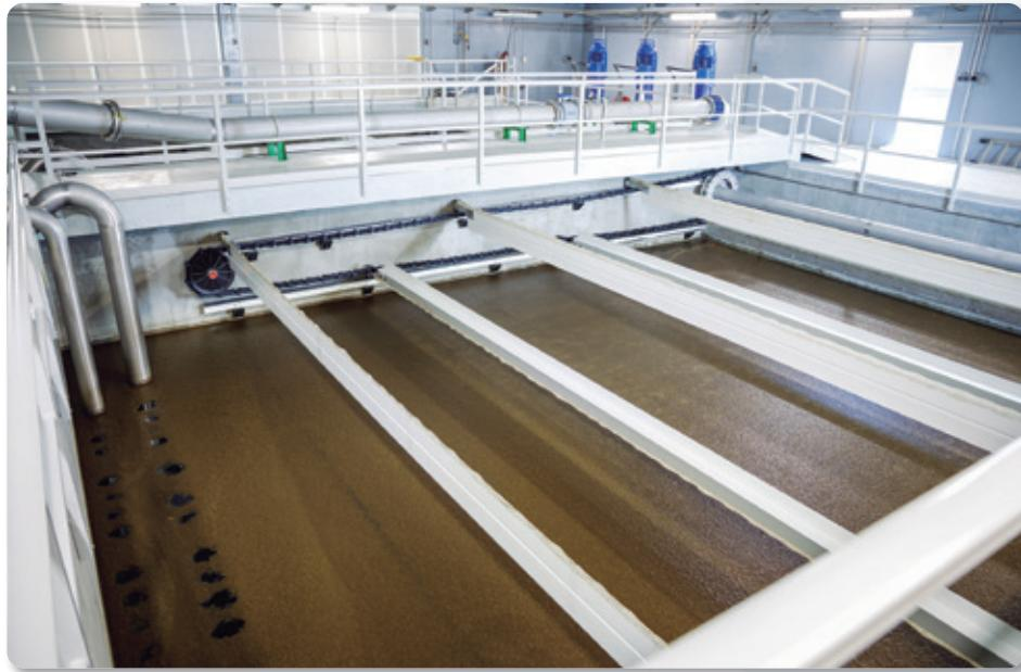
En la línea sólida se reconvirtieron los decantadores existentes en decantadores lamelares y se ha construido un espesador de fangos con el objetivo de disminuir el volumen de fangos a deshidratar, mejorando el rendimiento de esta etapa.
