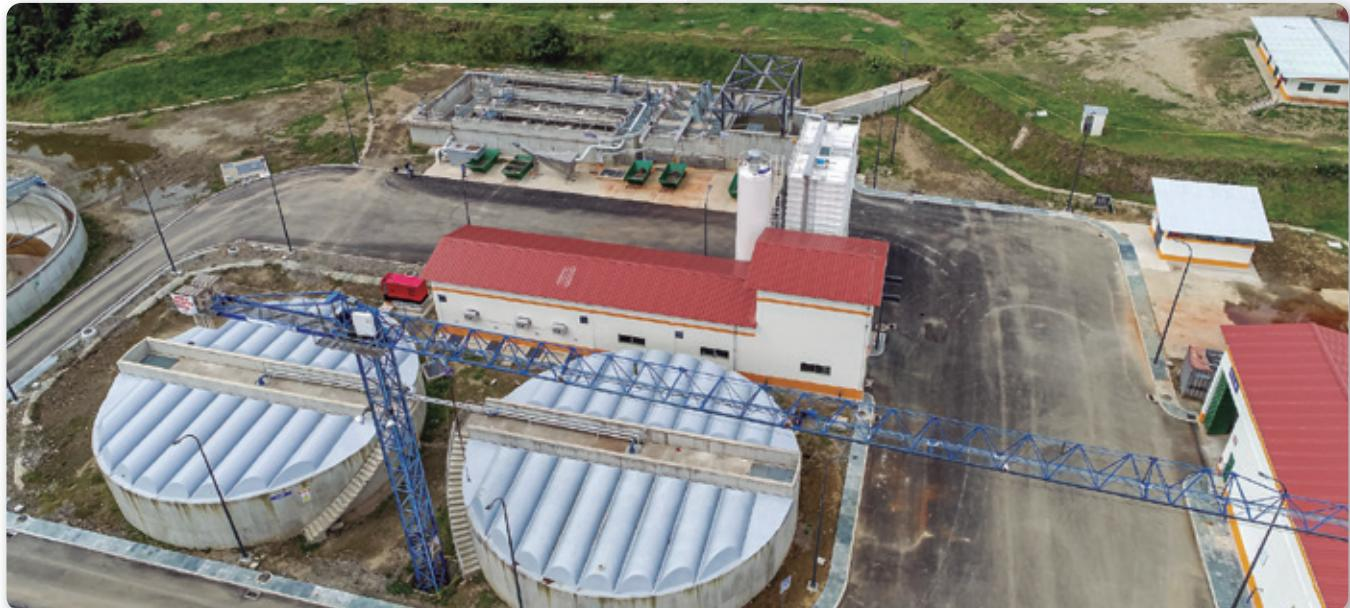
Los espesadores se han diseñado con un tiempo de retención hidráulica de 0.9 días, tomando una concentración o contenido en sólidos de los fangos espesados del 4,0%. El volumen de cada espesador es de 1328 m<sup>3</sup>, y la carga real de trabajo es de 42,8 kg/m<sup>2</sup>/día.
