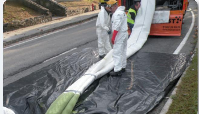
Sistema de rehabilitación SWL. Sistema de rehabilitación mediante manga polimerizada in situ | SWL rehabilitation system. Cured-in-place polymerised cloth rehabilitation system
