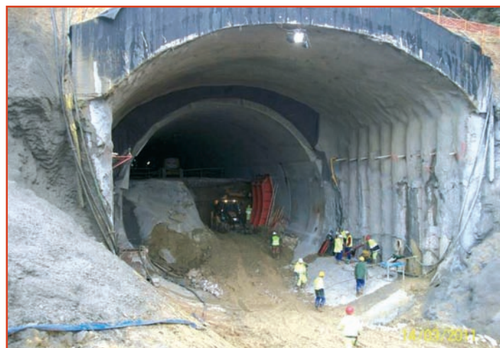
[Foto 9].- Construcción de la destroza y la contrabóveda del Túnel de Archidona (14/03/2011).
