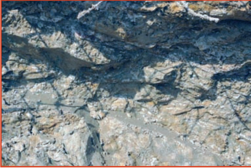
[Foto 4].- Zona tectonizada en el talud frontal por la presencia de una falla.
