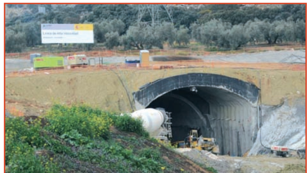
[Foto 7].- Viga de atado y revestimiento ya construido.
