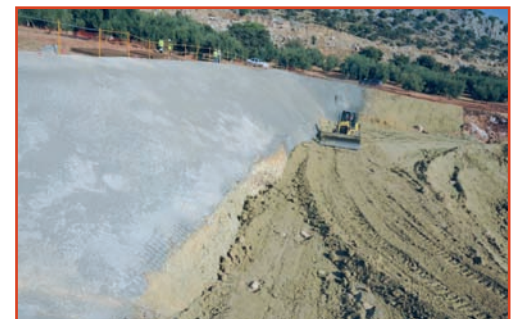
[Foto 2] .- Relleno con tierras del Portal Este.
