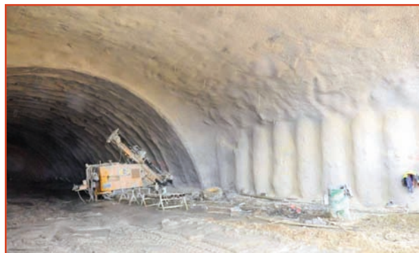
[Foto 5].- Estructura de pilotes y ejecución de un micropilote.
