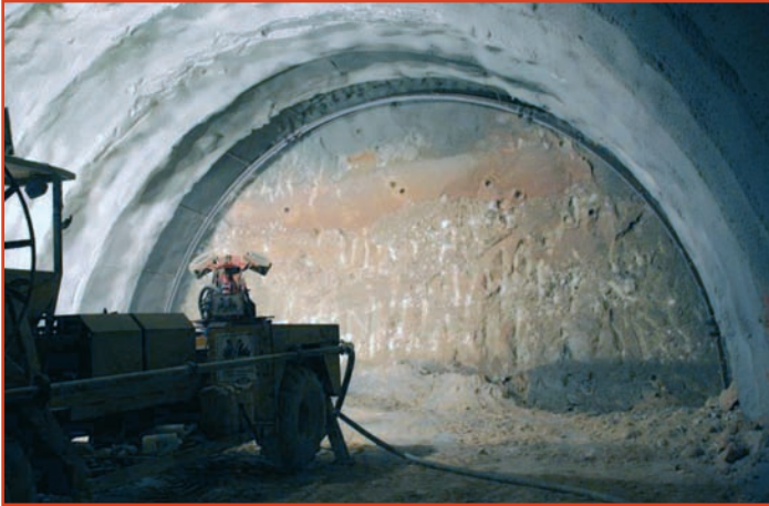
[Foto 1] .- Aspecto del frente del Avance del Túnel de Sant Celoni.
