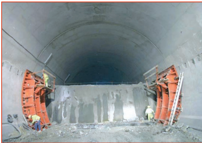
[Foto 10] .- Construcción de la Destroza y la Contrabóveda del Túnel de Archidona.
