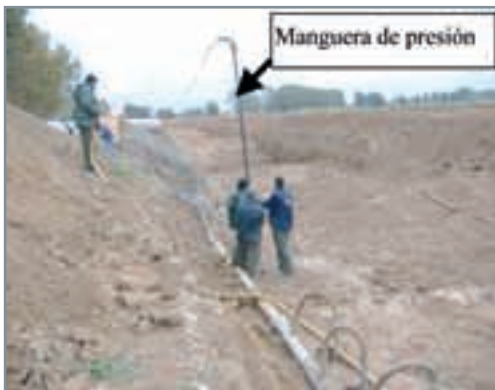
Introducción de la lanza en el terreno.
