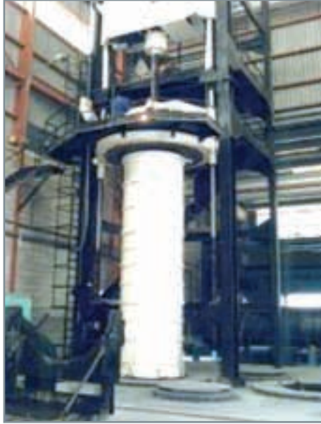
■ Turbomaster, hormigonado del núcleo por compresión radial.
