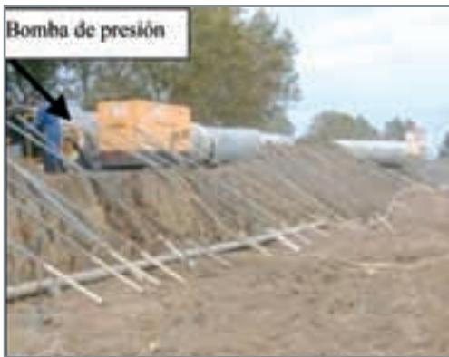
Introducción de la lanza en el terreno.
