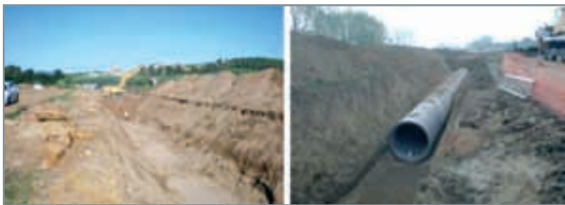
■ Zanja en terreno arenoso (Izda.) y zanja en terreno de textura media (Dcha.).
