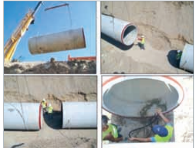
■ Proceso de montaje.
