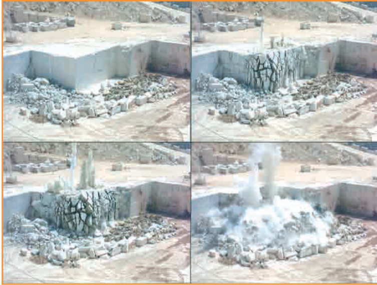
■ [Figura 6] .- Voladura con levantes en el Monte Coto de Pinoso.
