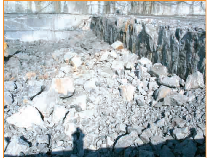
■ [Figura 7] .- Voladura con rozado horizontal inferior y precorte vertical en Markina (Guipuzkoa).
