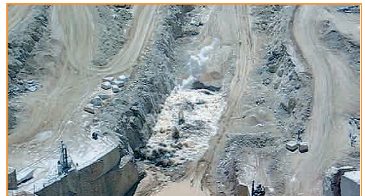
[Figura 5].- Voladura en zanja para acceso a bancos inferiores en Monte Coto de Pinoso.
