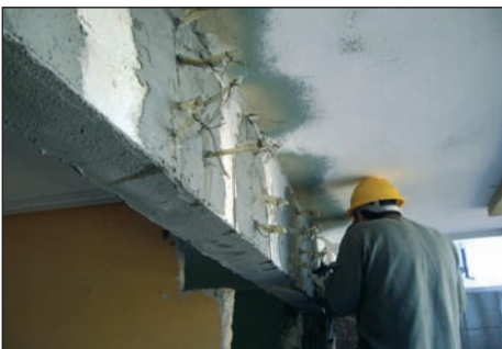
■ Inyección de resina epoxi para reparación de estructura de hormigón.
