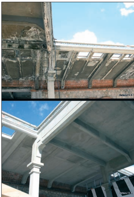
Vista de la estructura de hormigón de un edificio antes y después de la reparación.
