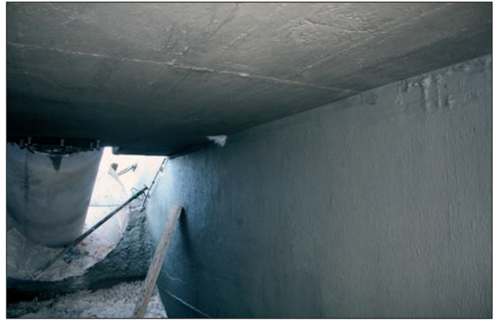
■ Vista de la reparación final de la estructura de hormigón y su armadura.
