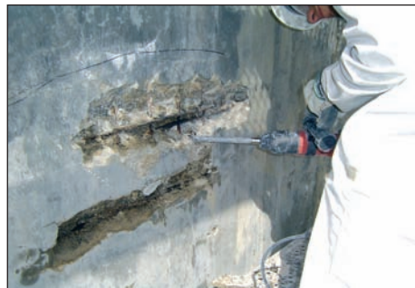
■ Saneamiento y descubrimiento de la zona deteriorada antes de su reparación.
