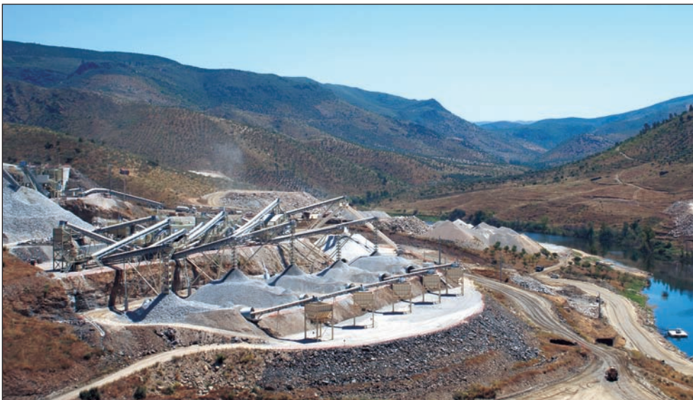
[Foto1].- La nueva planta para la presa en el Baixo Sabor produce alrededor de 750 th de arenas y áridos de alta calidad para producción de hormigón.
