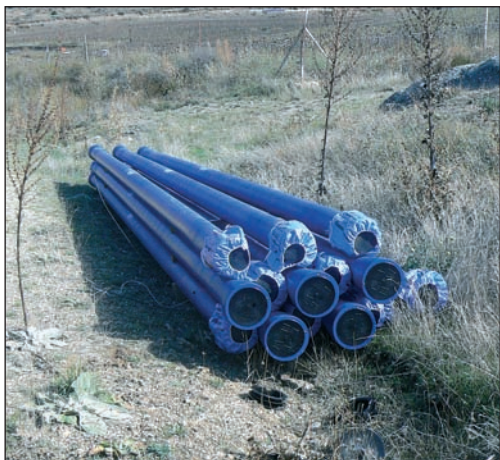
Conjunto de tubos Blutop PAM preparados para su posterior colocación en la zanja.
