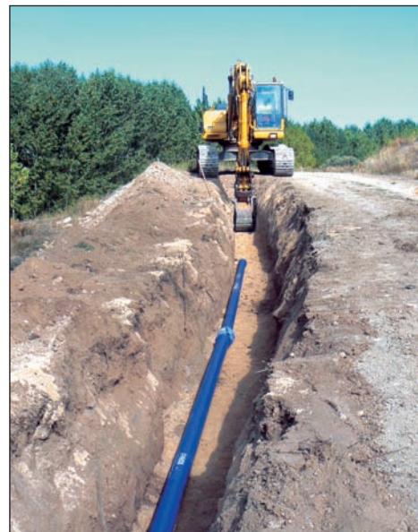
La tubería Blutop conectada y dispuesta en la zanja.
