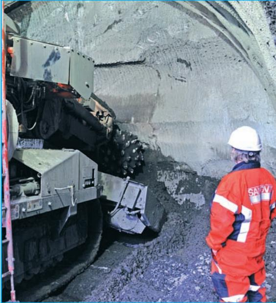
La rozadora Sandvik MT520 ejecutando el rozado del frente en los túneles de la Línea 3 del Metro de Bilbao.
