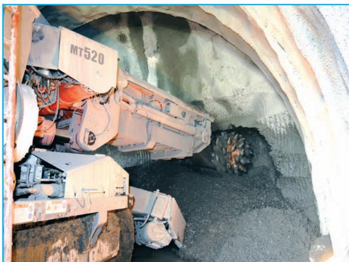
**Rozadora Sandvik MT520 de 115 t de peso; brazo telescópico de 1,2 m; motor de corte, 315 kW; velocidad de corte, 2,9 m/s; y potencia total instalada, 537 kW.**
