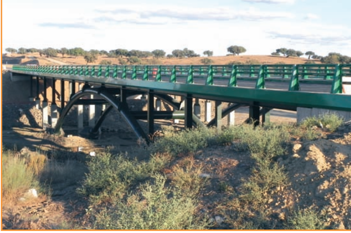
■ Vista lateral del viaducto sobre el río Arrago.
