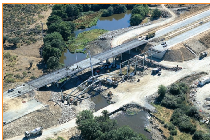
Ejecución del viaducto sobre el río Árrago.
