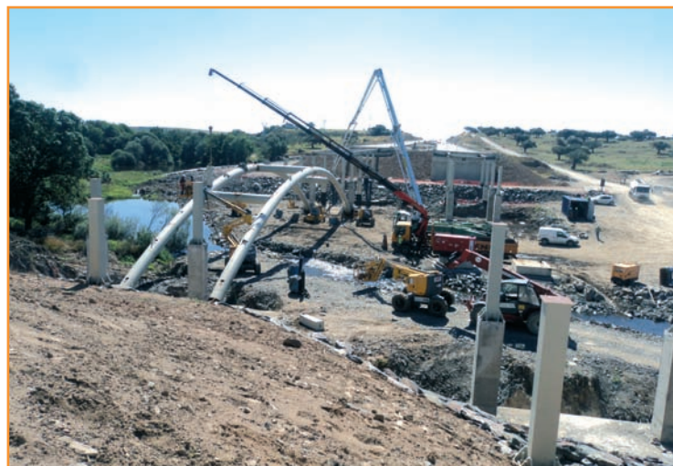
■ Pilares y arco metálico para el soporte del viaducto sobre el río.
