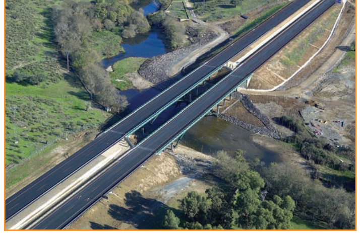
■ Vista aérea del viaducto sobre el río Arrago ya ejecutado.
