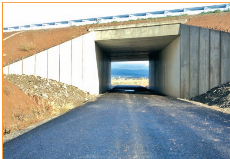
■ Paso inferior para restitución de vías de comunicación afectadas.
