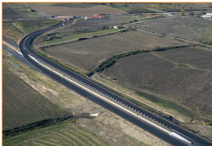
■ Vista de una parte del tramo de autovía ya terminado.
