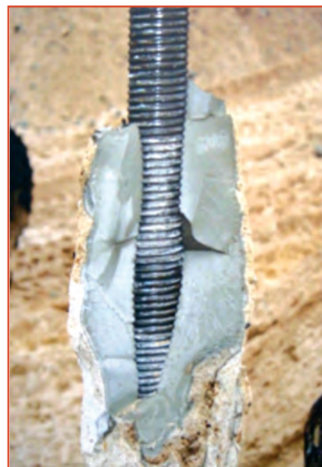
Detalle de zona de bulbo de un Micropilote Titan
