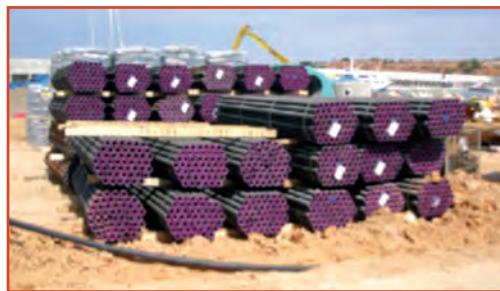
Acopio de armadura autopercutor autoinyectante.
