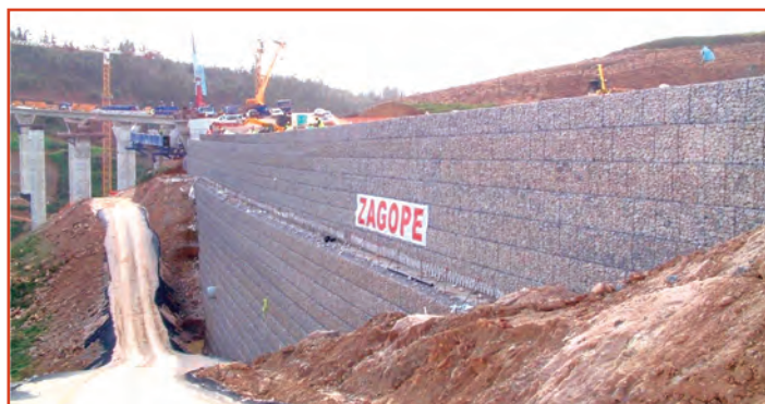
[Fig. 1] .- Muro de suelo reforzado Paramesh ® de 26 m de altura diseñado y ejecutado por Bianchini en la Autopista A2. Tramo Ericira - Mafra (Portugal, 2007).
