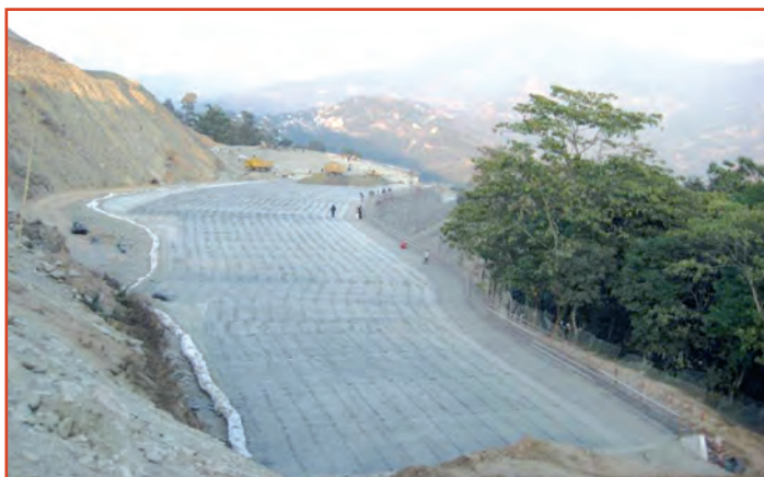
[Fig. 34].- Vista general de la Obra donde se aprecian las geomallas Paralink®.
