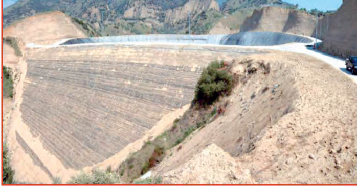
[Fig. 3] .- Mota de contención con suelo reforzado y técnica del Wrap - Around (envuelta de las geomallas en el paramento exterior) de 47 m de altura ejecutada en el Vertedero de Aydin, Turquía (2007).
