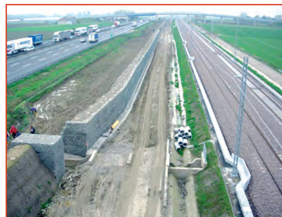
■ [Fig. 23].- Vista general de la Obra.
