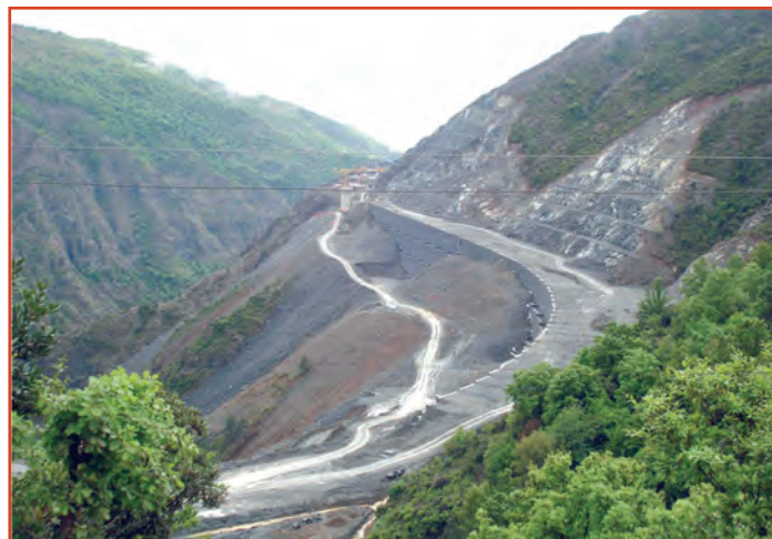
[Fig. 27].- Muro Paramesh® en construcción. Puede apreciarse la pendiente de la ladera por la que transcurre la autopista.
