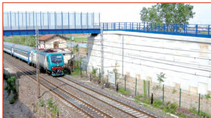
[Fig. 2] .- Muro Macres ® de 9 m de altura de escamas de hormigón y refuerzo sintético Paraweb ® ejecutada en Italia (2008).
