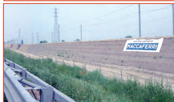
■ [Fig. 24].- Tramo de Duna 60/60, ya finalizado.
