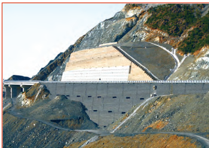
[Fig. 28].- Doble estructura Paramesh® , como sistema de contención (muro inferior, de altura 37 m) y como muro situado a pie de ladera (muro superior, de 35 m de altura).
