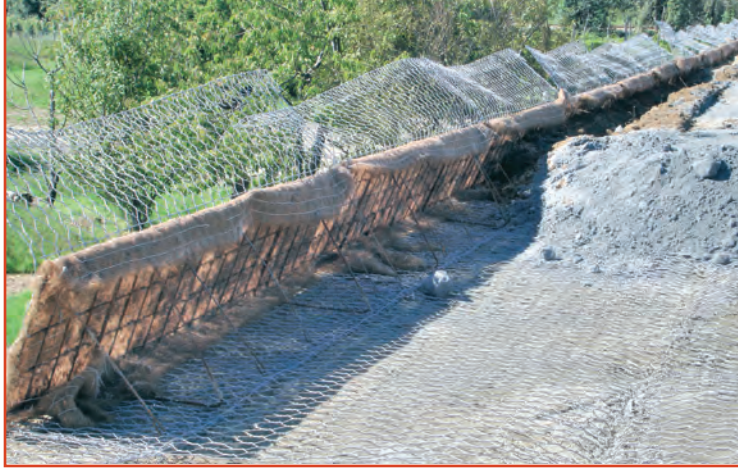
[Fig. 10] .- Instalación de módulos Green Terramesh®.
