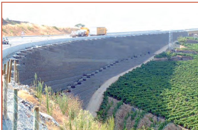
[Fig. 18] .- Vista desde la carretera de los muros Paramesh terminados.
