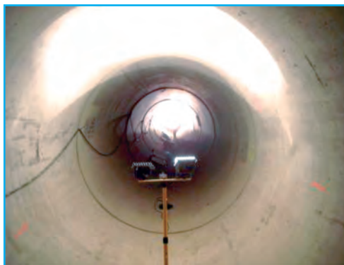
Vista desde el interior del solape de las tuberías.
