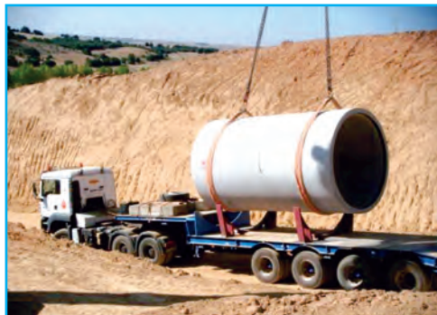
■ Montaje directo de la tubería desde el camión.
