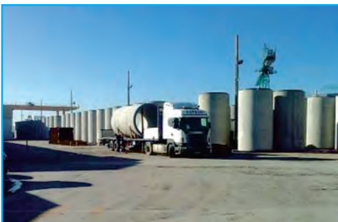
■ Vista del área en fábrica del acopio y curado de tuberías.
