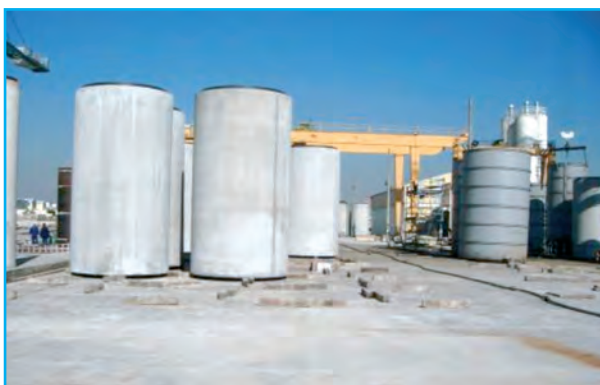
■ Fabricación de tuberías con camisa de chapa.
