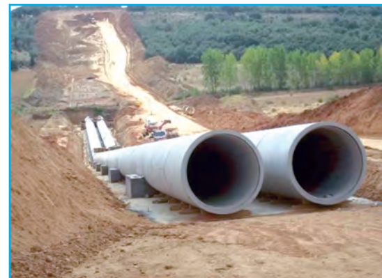
[Fig. 29].- Ejecución de la excavación en la zona de máxima cobertura.
