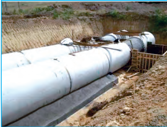
Preparación de las tuberías en la zanja antes de su posterior relleno.
