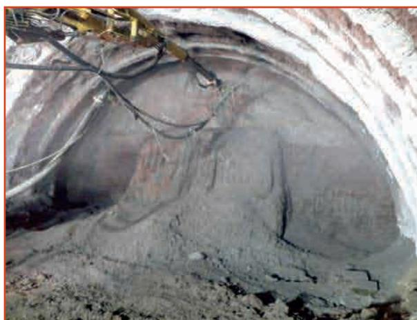
■ [Fig. 33].- Estabilización del frente de excavación.
