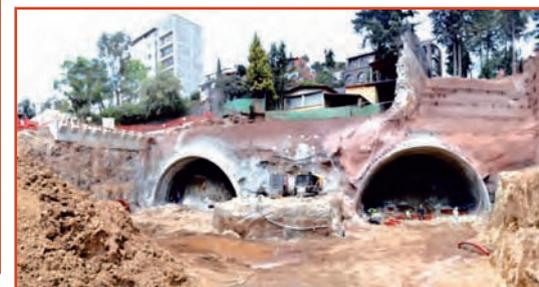
[Fig. 23] .- Excavación del portal Sur, donde se presentó la menor cobertura (8m).
