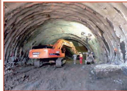
[Fig. 29].- Ejecución de la excavación en la zona de máxima cobertura.
