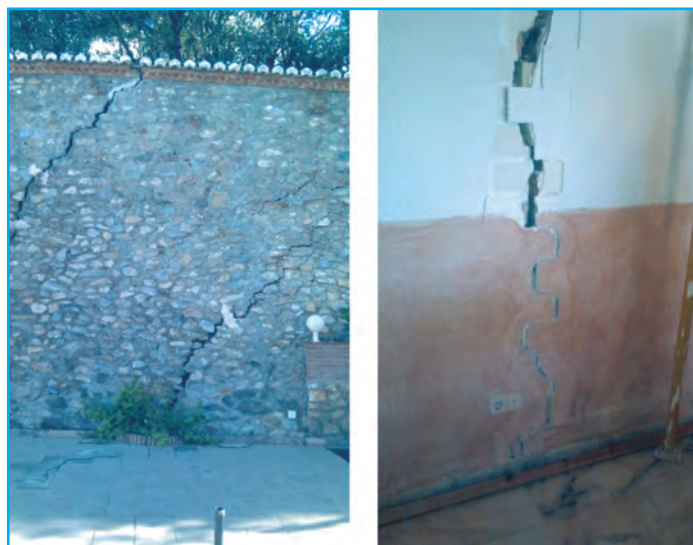
■ Grietas aparecidas en fachada e interior de la vivienda
