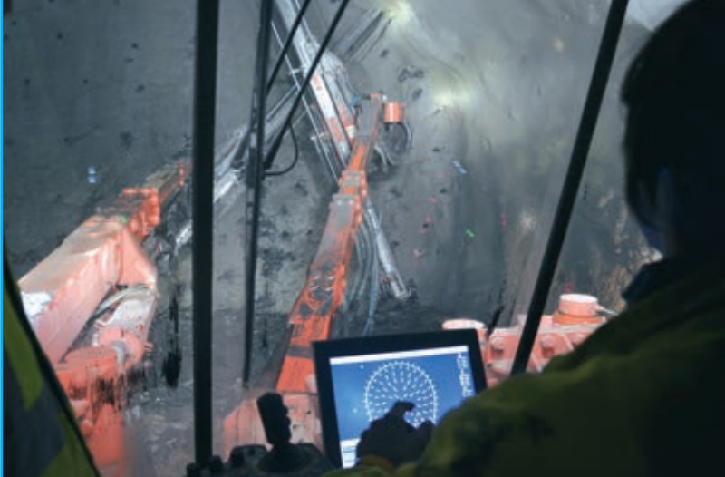
■ Frente del tunel y pantalla de control del esquema de perforación.
