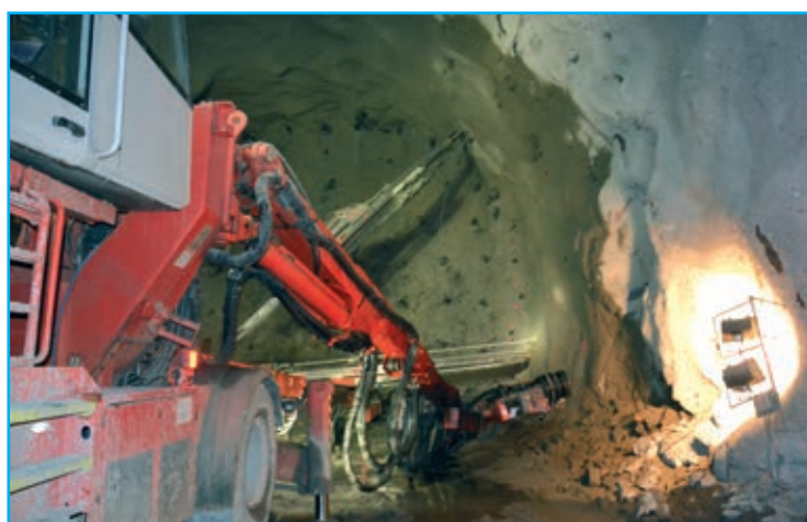
El jumbo DT 1130i realizando labores de perforación en el frente según el esquema de tiro prefijado.
