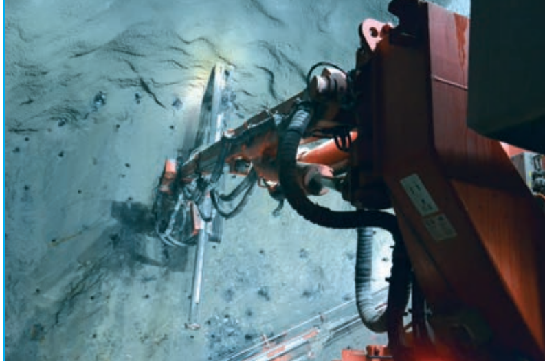
■ Bulnaje lejecutado por uno de los jumbos utilizados en la excavación.
