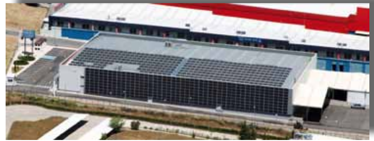
▽ Imagen 2: Fachada y Cubierta Sur del Edificio después de la rehabilitación.
