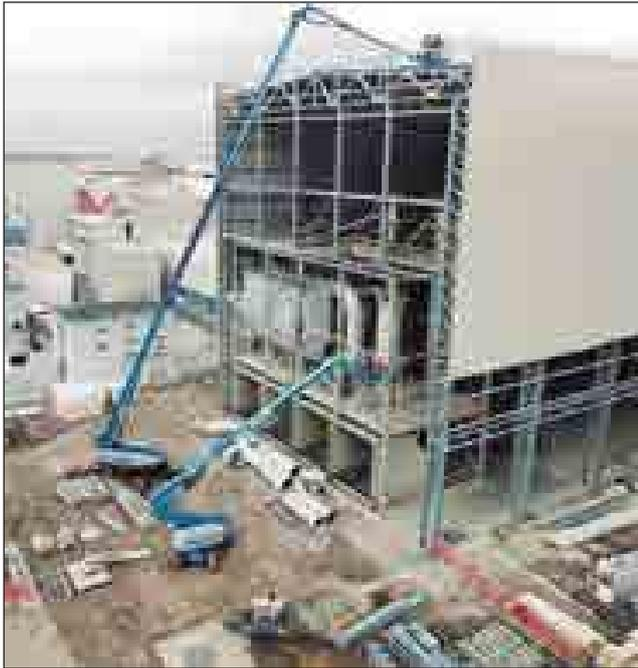
**El Genie Jib Extend telescópico permite alcanzar una altura de trabajo máxima de 43 m y 27,43 m de alcance horizontal.**
