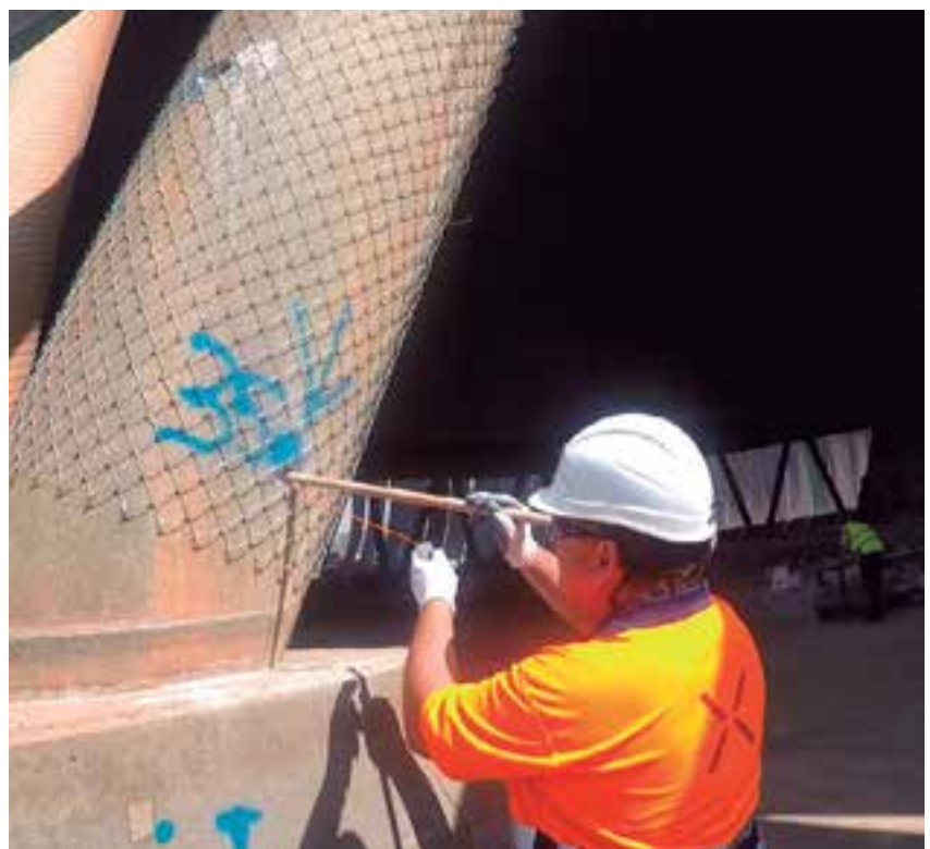
Atacado del explosivo durante el proceso de carga de la voladura.
