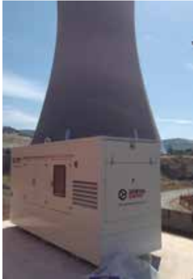
instalación del sismógrafo en la subestación eléctrica de REE a 105 metros de la torre.
