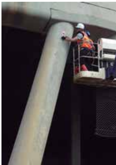
Colocación de la malla de torsión simple alrededor de los pilares para evitar proyecciones.
