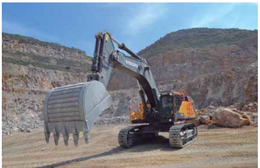
Una excavadora de cadenas Volvo EC750E en la cantera de Garraf.
