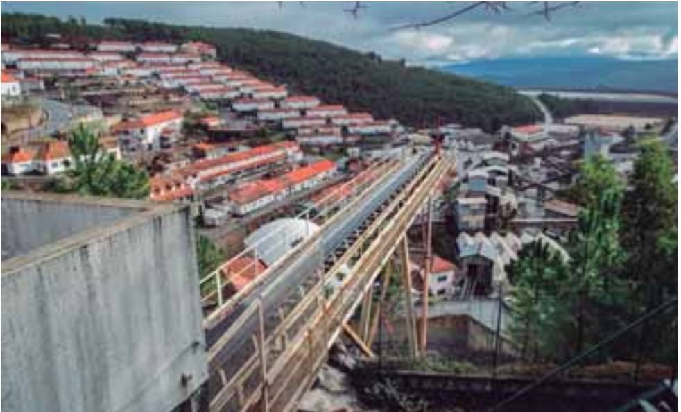
Figura 5. Vista general de la planta de tratamiento de Panasqueira
