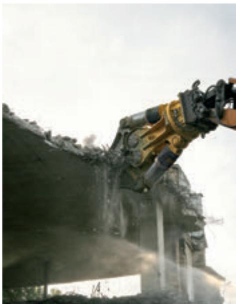
Epiroc ha añadido dos nuevos modelos a su popular gama de mordazas para hormigón CB para máquinas portadoras más pesadas: las CB 5500 y CB 7500, diseñadas para las de 50 a 85 toneladas. Debido a sus pesos relativamente ligeros, estas mordazas constituyen una elección efectiva para máquinas portadoras con un gran alcance en altura o de frente largo, así
