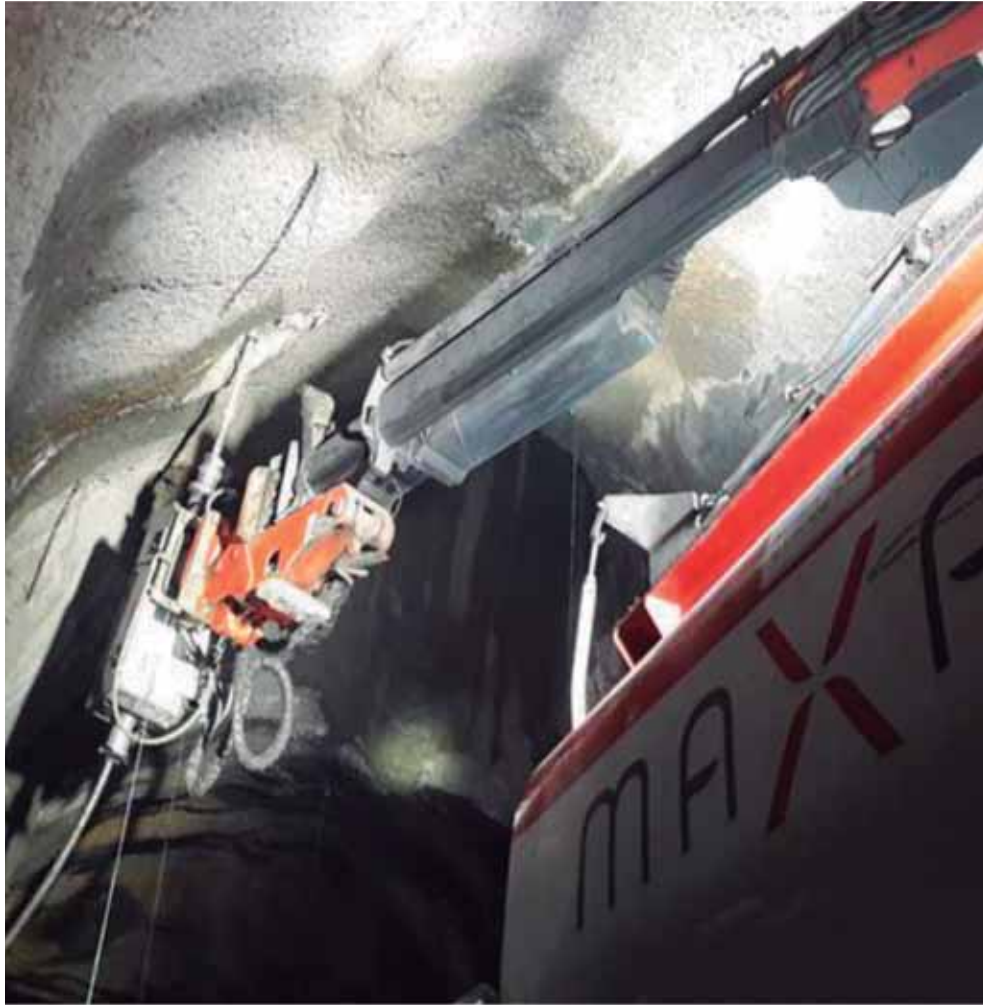
Figure 4. Operación de medición de barrenos
