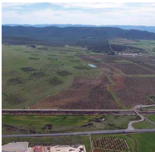
Centro minero tras trabajos de restauración ambiental Espiel 2016
