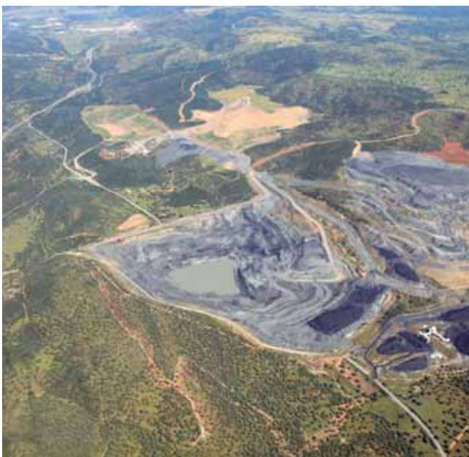
Centro minero con actividad de extracción Estercuel 2012.
