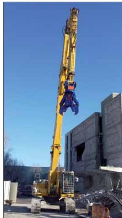
El demoledor primario de Trevi dispone de características especiales para la demolición de hormigón y los dientes de la pinza diseñados para este fin.
