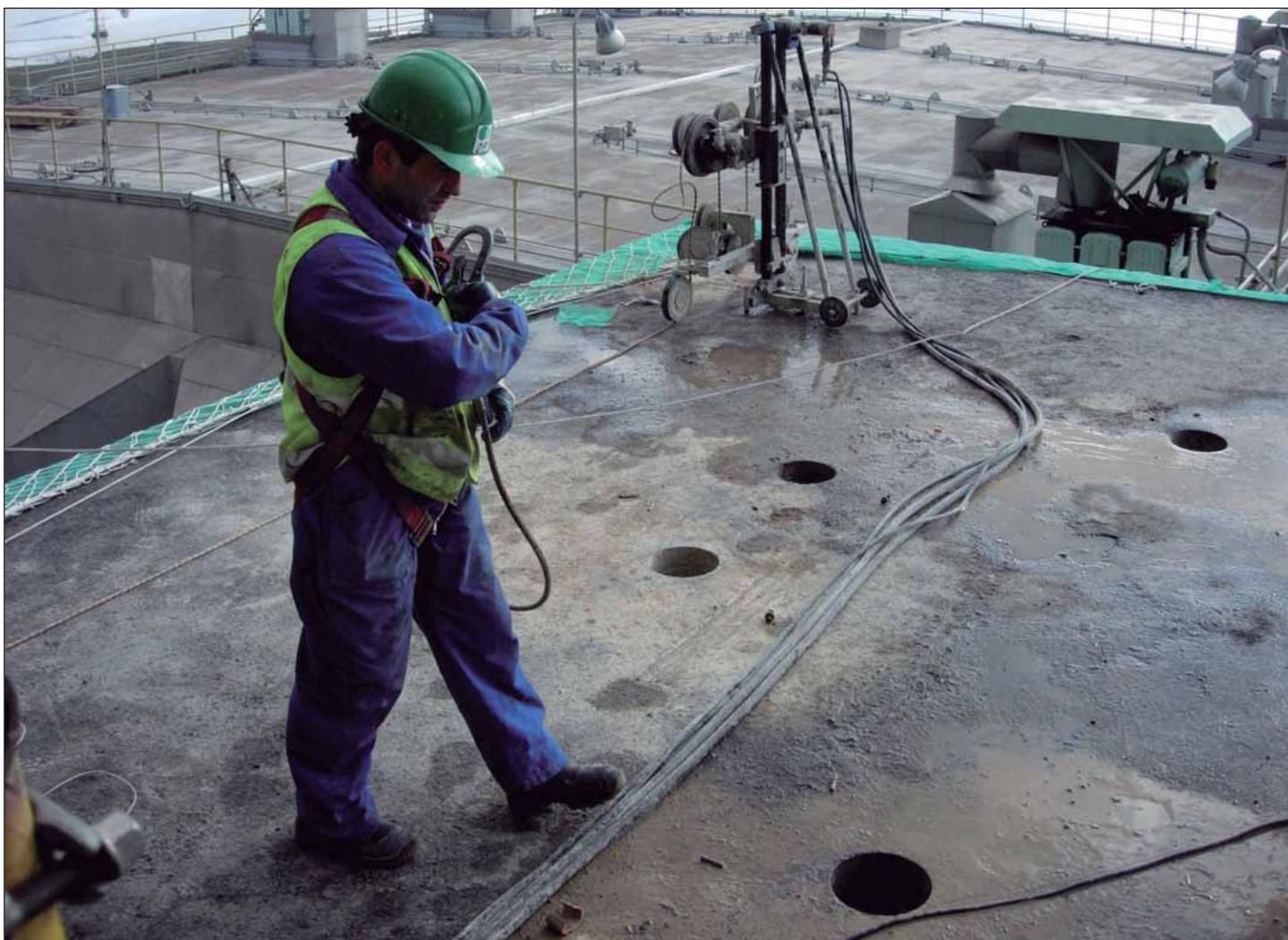
● Sierras de corte circular, o compás de hilo, que se usan para realizar cortes circulares de hasta 6 metros de diámetro (es preciso tener acceso a ambas caras del material a cortar).
