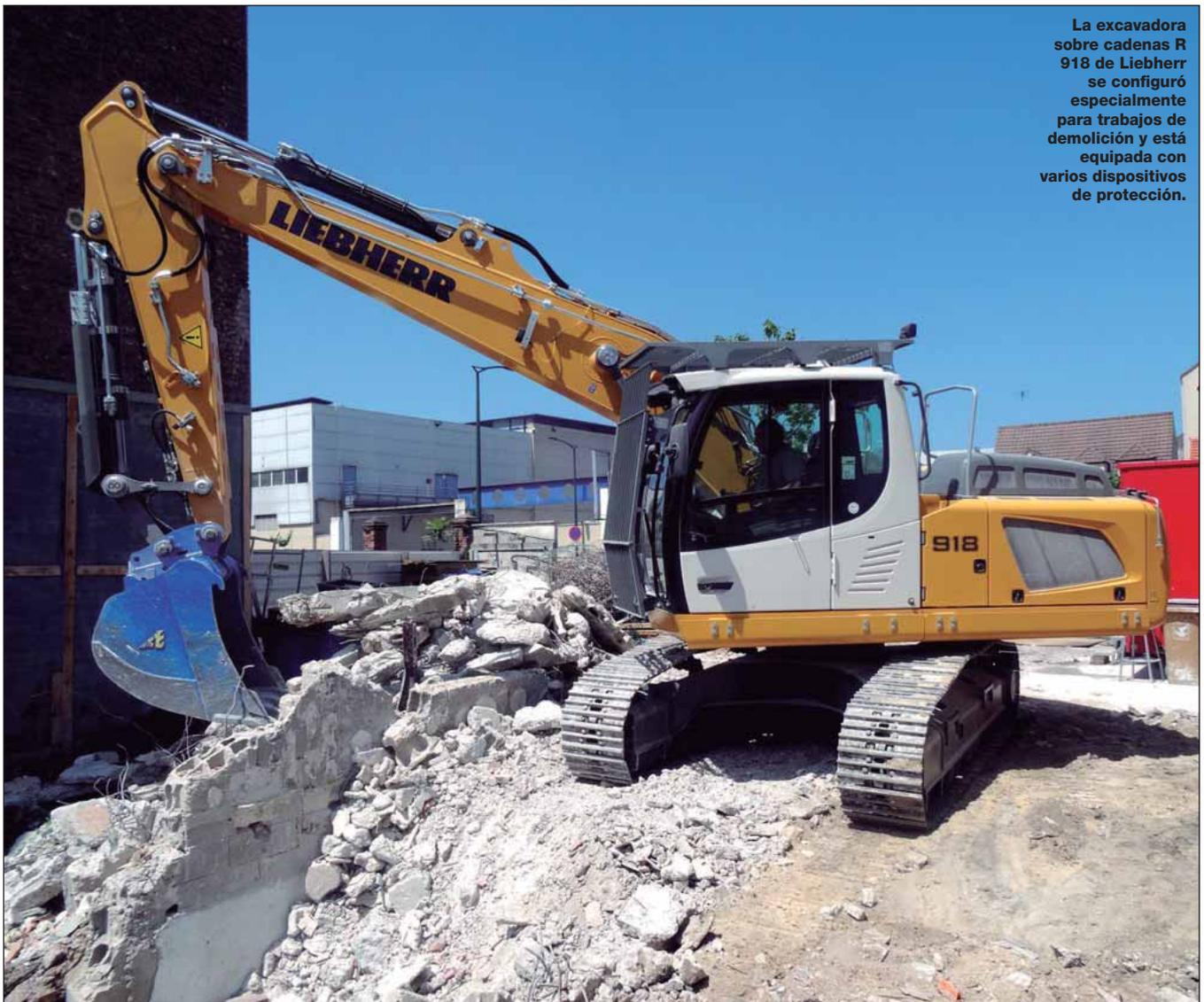
La excavadora sobre cadenas R 918 de Liebherr se configuró especialmente para trabajos de demolición y está equipada con varios dispositivos de protección.
