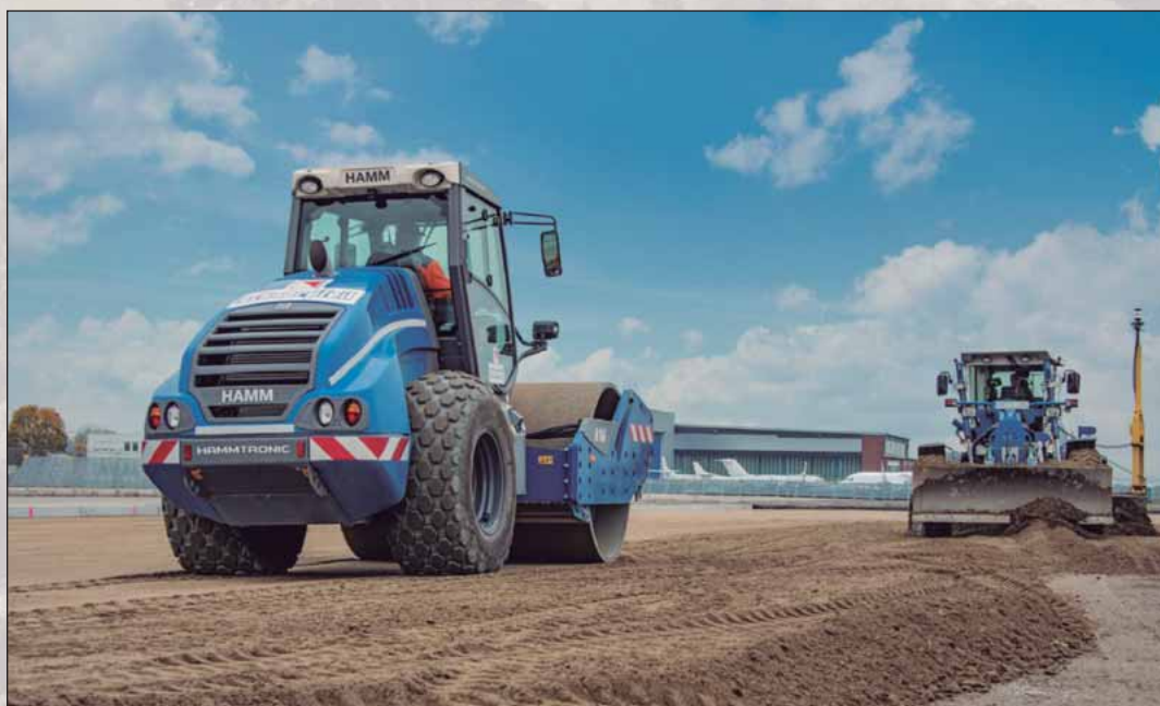
La compactación de la capa de base ligada de forma hidráulica se realizó en el aeropuerto de Colonia/Bonn con un compactador de Hamm H 16i.
