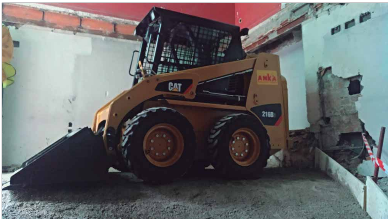
Cargadora CAT 216B3 empleada en los trabajos de desescombro del Hotel Rex.
