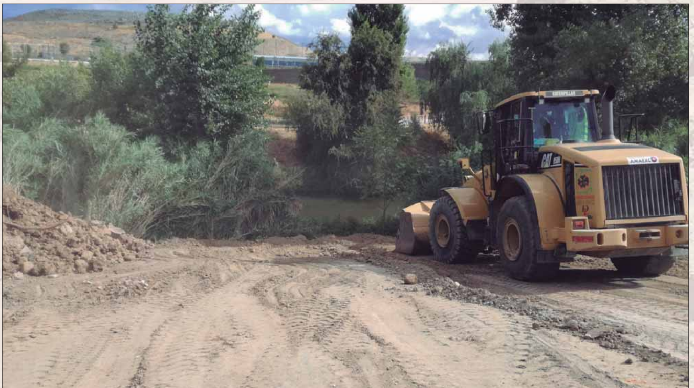
Actuaciones en Perales del Río, junto al Manzanares.
