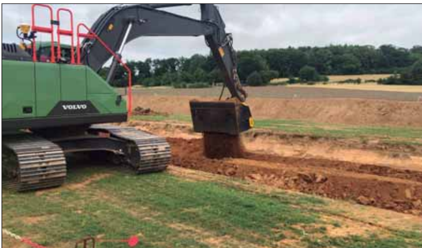
Trabajos en el proyecto piloto Wahle-Mecklar, en Alemania.
