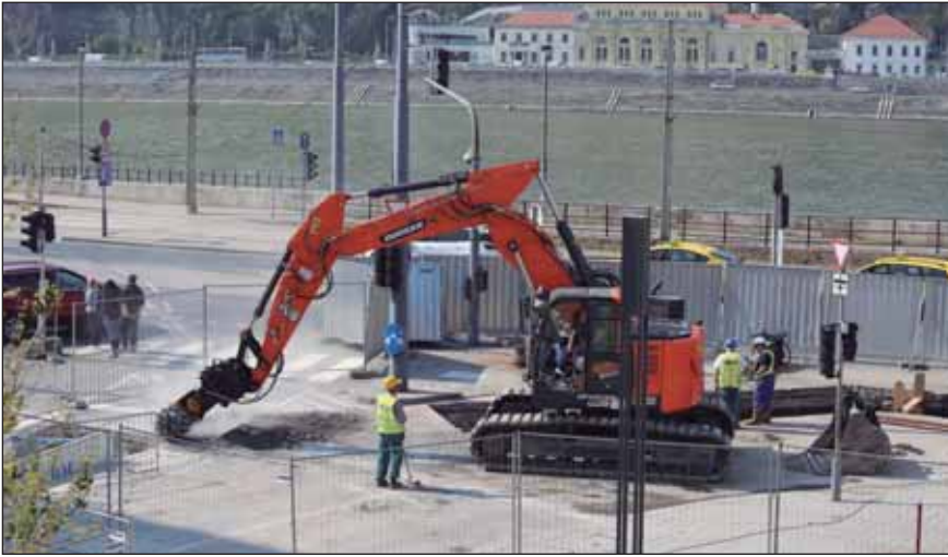
Fresa MB-R900 para cavar una zanja cerca del puente que conecta Buda y Pest, en Hungría.
