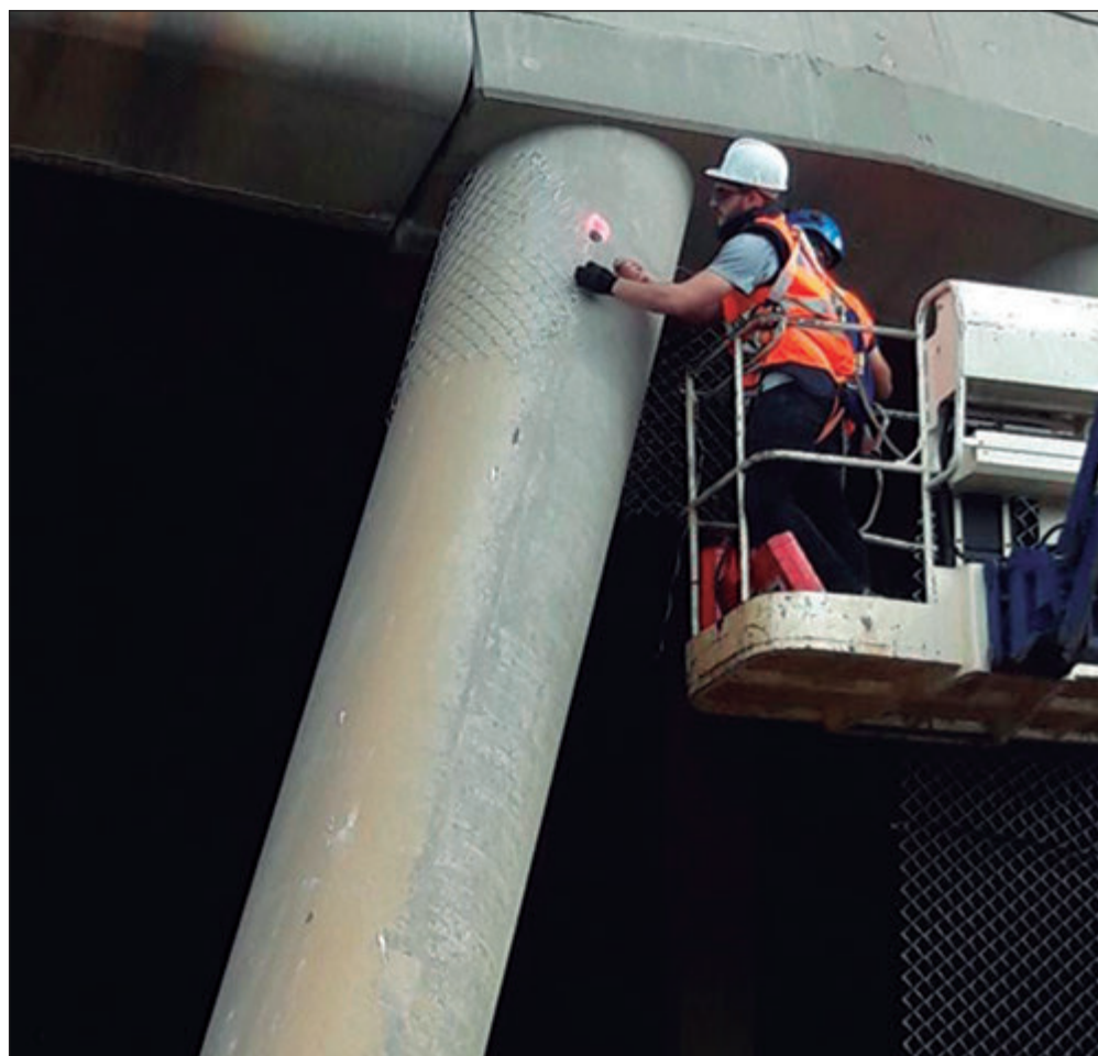
Colocación de la malla de torsión simple alrededor de los pilares para evitar proyecciones
