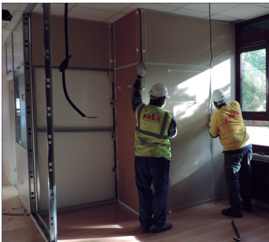
Dada la singularidad de la obra, los trabajos de demolición debieron hacerse de forma manual.
