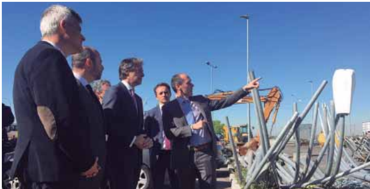
Íñigo de la Serna, ministro de Fomento, en la visita a las obras de ampliación de la A-5.
