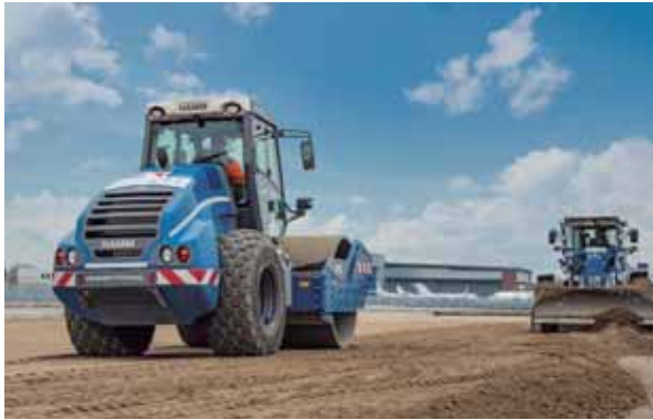
La compactación de la capa de base ligada de forma hidráulica se realizó en el aeropuerto de Colonia/Bonn con un compactador de Hamm H 16i.
