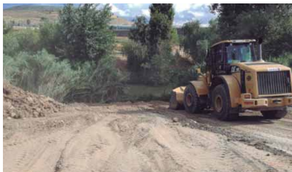
Actuaciones en Perales del Río, junto al Manzanares.
