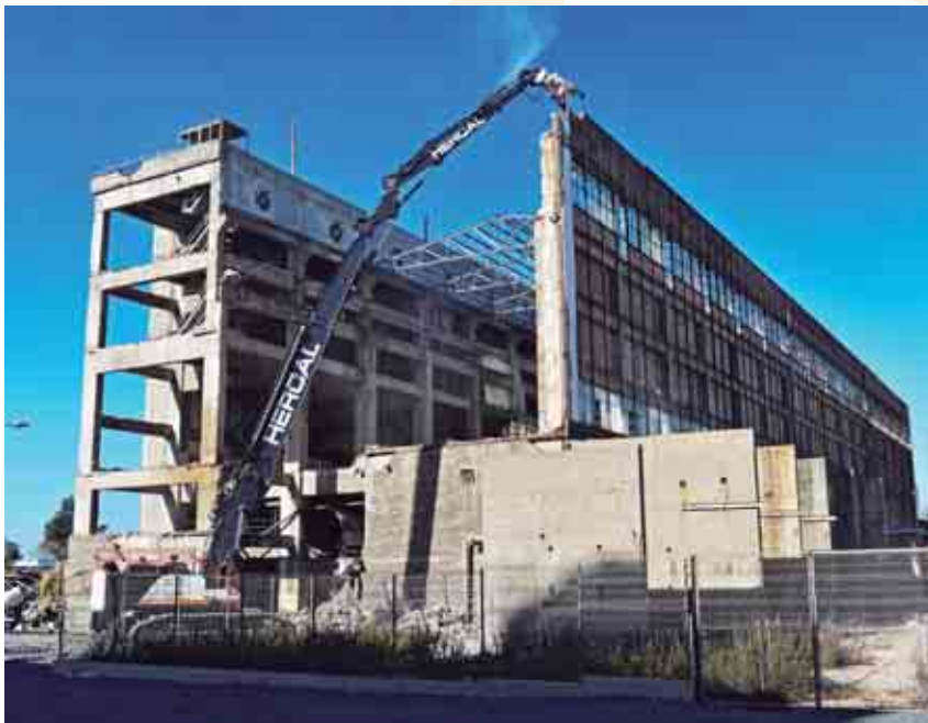
Brazo telescópico Volvo EC750 trabajando en la obra.
