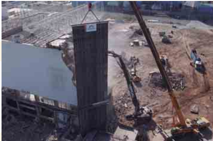
Uno de las principales innovaciones para realizar la demolición sin riesgos fue el uso de una pantalla de protección sustentada por una grúa autopropulsada.
