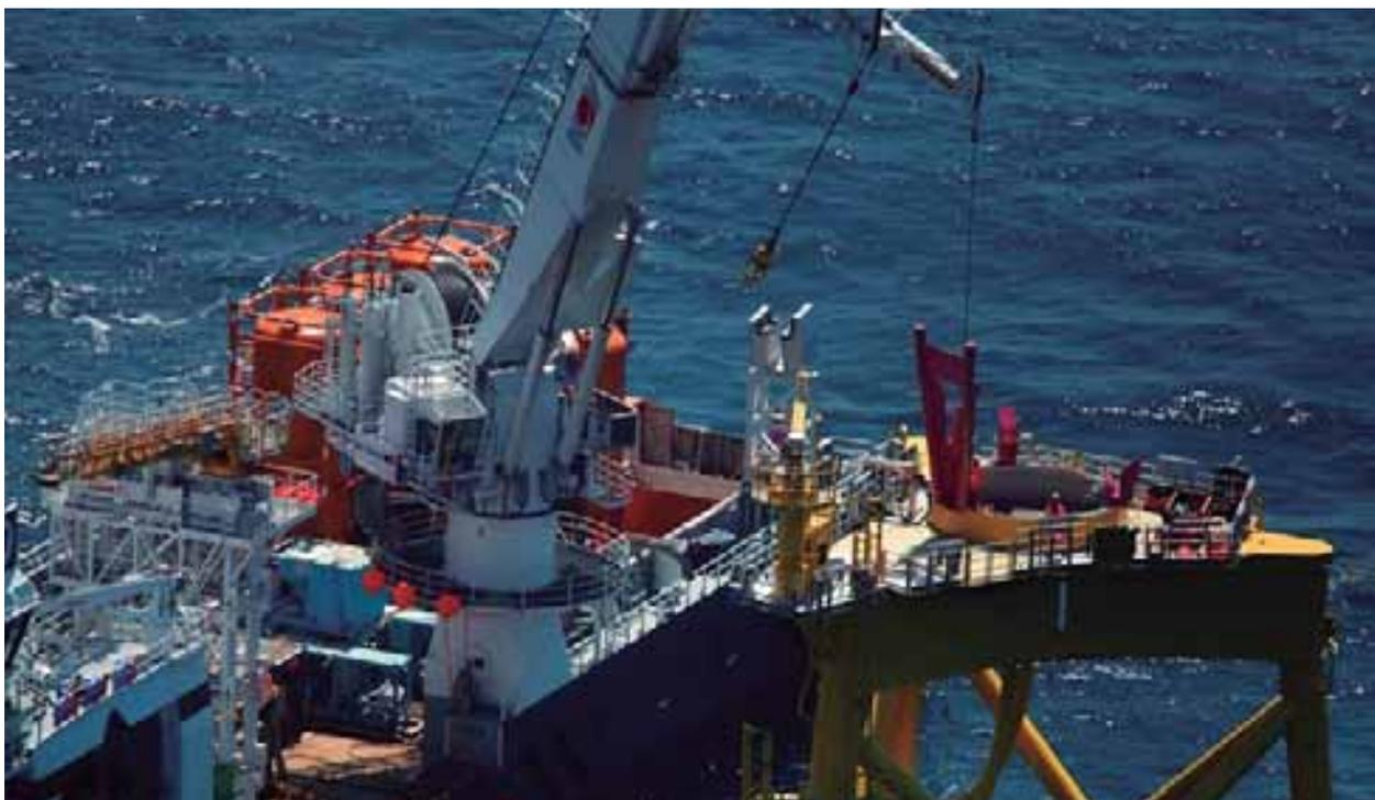
**I**berdrola avanza en el proyecto del parque eólico marino (offshore) de Iberdrola East Anglia One en aguas inglesas y ha iniciado la instalación de las primeras jackets, construidas por Navantia en el astillero de Fene, y los pilotes, realizados por Windar en Avilés.
