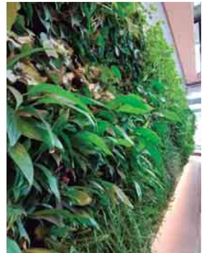
tructuras está rellena de sustrato para el cultivo y la otra permanece vacía generando un espacio hueco para la circulación del aire. Entremedias de las dos capas se coloca una tela hidrófila para la distribución trasera del riego. La capa exterior contiene sustrato orgánico enriquecido, permitiendo un desarrollo completo de las raíces para favorecer la biofiltración por microorganismos.
