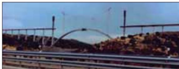
**El semiarco está sustentado mediante tirantes que transmiten su esfuerzo a torres metálicas de atirantamiento provisional.**
