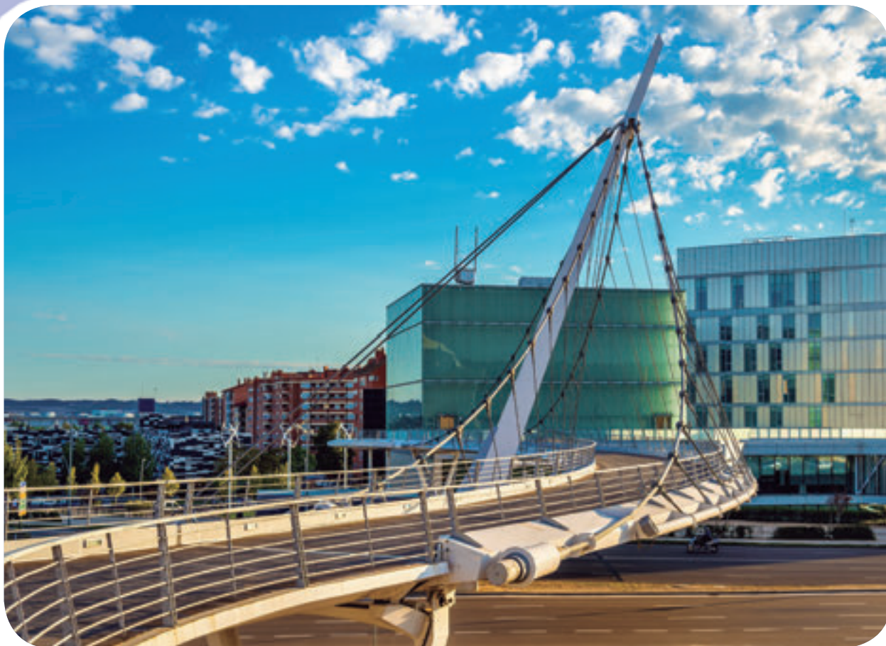
Estación de Zaragoza-Delicias.
