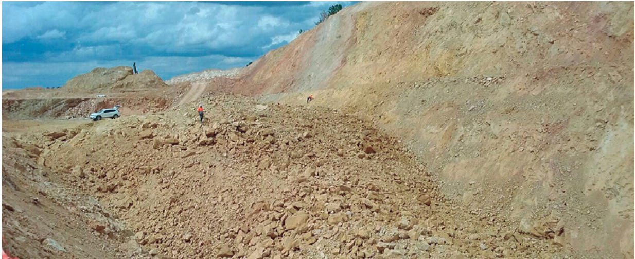
Voladura de Destroza
